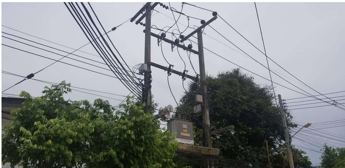
รูปภาพที่ ๗ ภาพหม้อแปลงไฟฟ้าก่อนการปรับปรุงของโรงพยาบาลห้วยทับทัน
